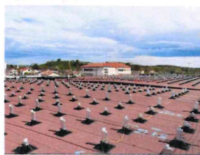
Pose des supports des panneaux photovoltaïques :
